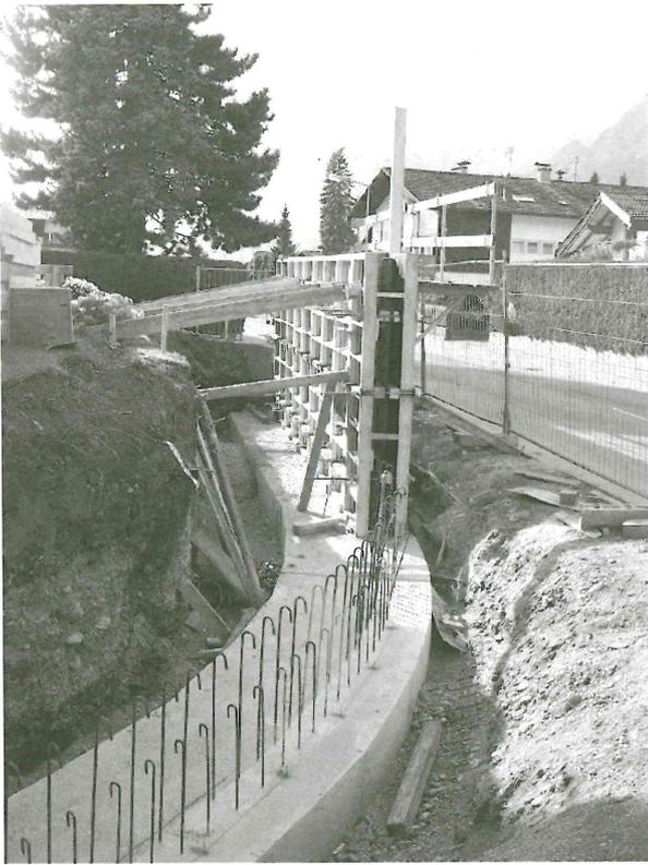
Mühlfeldlift wird eine 1,00 m breite Entwässerungsmulde mit Sickerpackung und Muldeneinläufen errichtet. Die Bankettbreite beträgt 1,00 m; im Gehsteigbereich 0,25 m. Die Längsneigung in der Straßenachse wurde im Zuge der Planung möglichst an den Bestand angepasst. Die Querneigung beträgt durchwegs 2,5 %.
